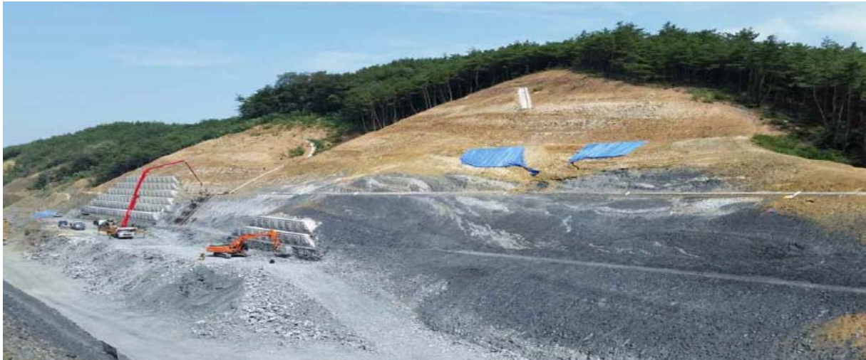
그림 2.16 2016. 12 절토사면 공사 현황
