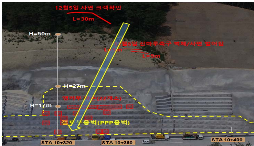
그림 4.2 추가 지반조사와 현장 손상 내용을 종합한 예상활동 방향
